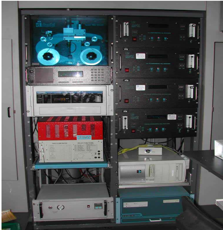
Figura 1: Strumentazione del laboratorio mobile
